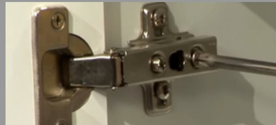
reparacion bisagras puertas armario
