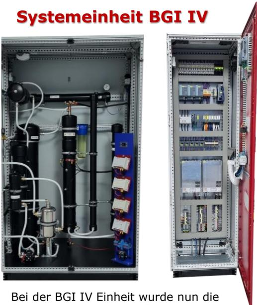
Bei der BGI IV Einheit wurde nun die Prozesseinheit von der Gesamtsteuerung getrennt. Elektrik und Elektronik bilden nun eine eigene Einheit. Hierdurch ist es möglich die Prozesseinheit zukünftig noch weiter Auszubauen bzw. zu ergänzen.
