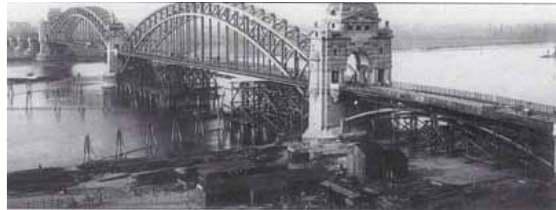
Die Oberkasseler Brücke im Bau 1898
