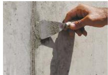
Anschließend werden Abstandshalter bis zu einer Tiefe von 2-3 cm im Beton ausgestemmt und mit **DUROCRET**, **DUROCRET-FAST** oder **DUROCRET-PLUS** ausgemörtelt. Betonester sowie vorhandene Arbeitsfugen, die vorher in V-Form geöffnet worden, werden mit dem gleichen Reparaturmörtel ausgemörtelt. Außen im Wand-/Sohlenanschluss wird mit dem Reparaturmörtel eine Hohlkehle hergestellt. Bei Mauerwerksflächen sind die Fugen vollfugig mit den o.g. Reparaturmörteln zu verspachteln.
