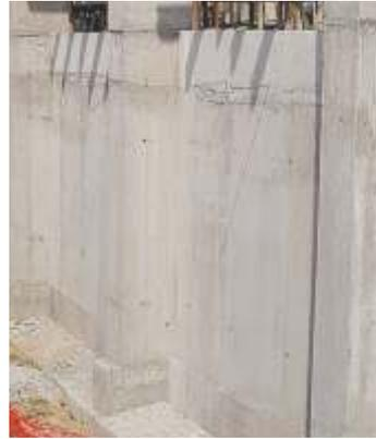
Zunächst sind die Oberflächen (Beton bzw. Mauerwerk) von Schalungsresten, losen Bestandteilen, Staub u.ä. gründlich zu reinigen.
