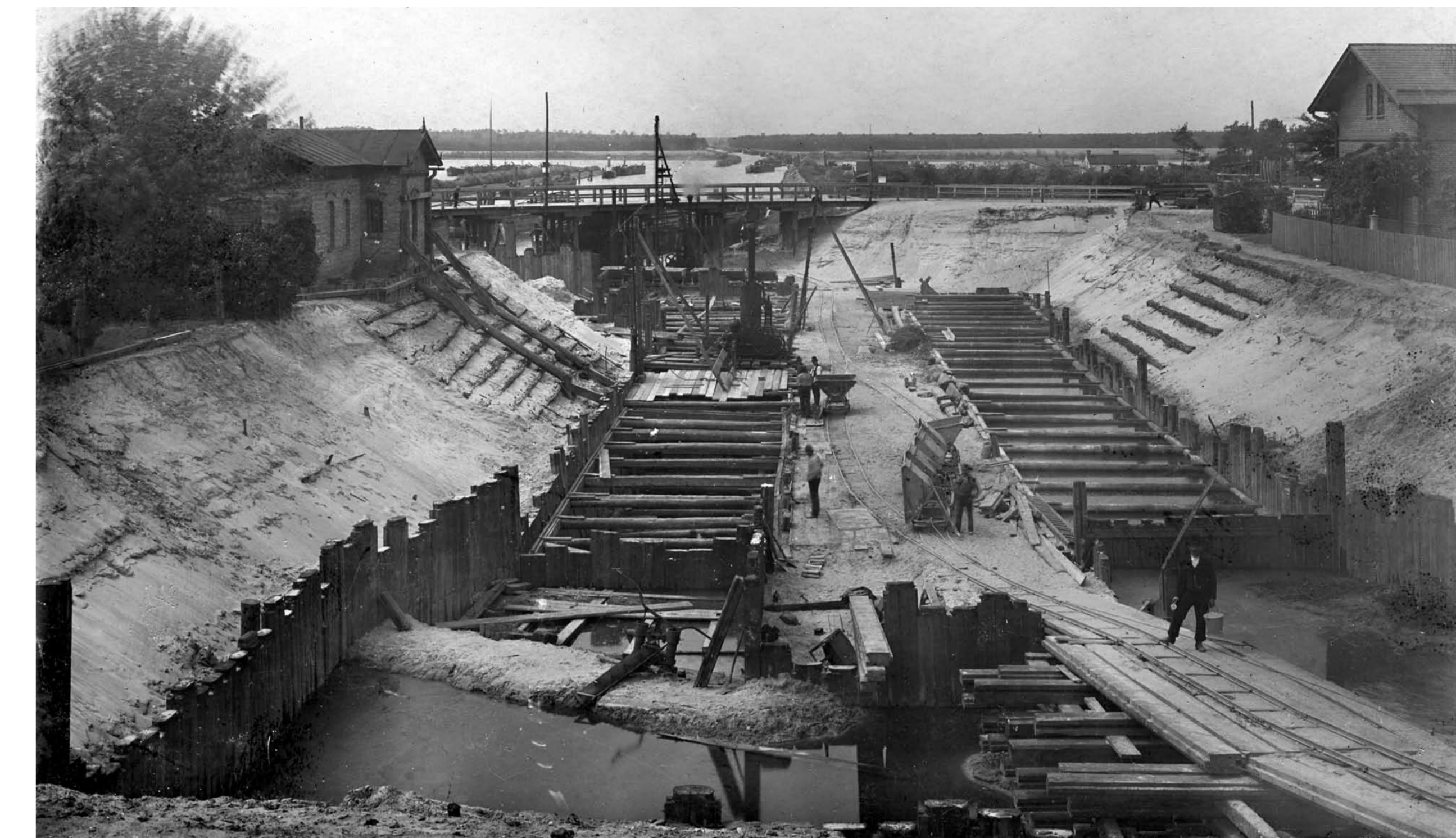
Bau der zweiten Schleusenkammer der Schleuse Wernsdorf am 13.6.1902
