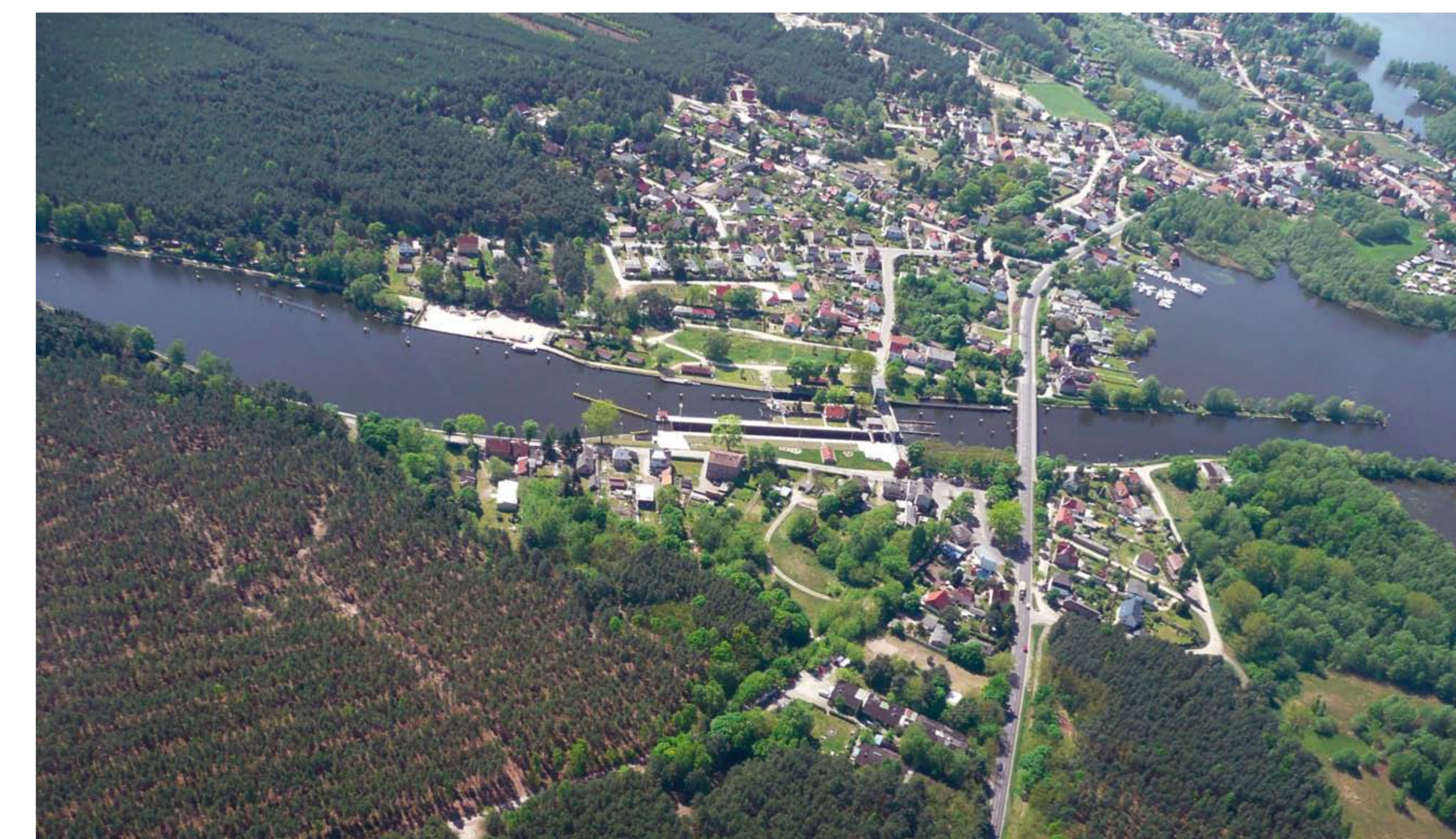
Schleuse Wernsdorf, Photo Ulrich Gerwin 2008
