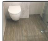
**Wartungsfreie Abdichtung:** Durch das von uns angewandte Pressfugenverfahren, benötigen wir für die Abdichtung im direkten Nassbereich keine Wartungsfugen. (Silikon)
