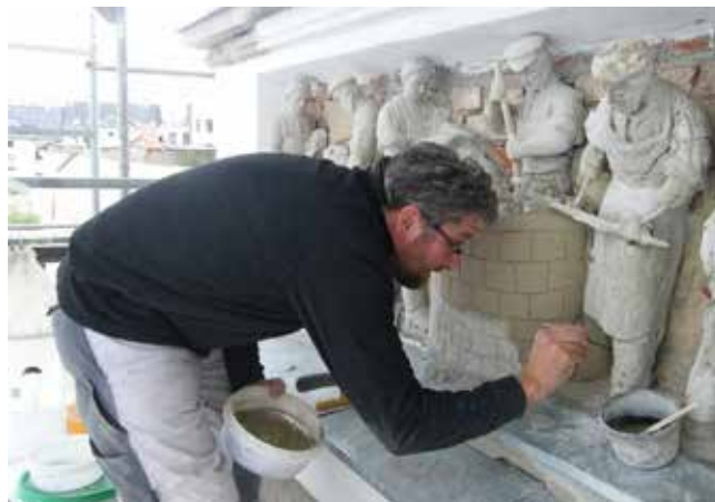
Restaurierungsarbeiten am Tuchmacherfries.
