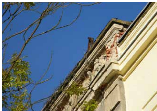
Otto-Ullrich-Bau mit Tuchmacherfries, Detail (2012)
