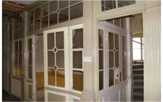
1.OG: Gründerzeitliche Abtrennung (Treppenhaus - Wohnung).
