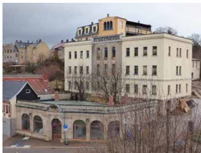
„Tuchfabrik“. Mitte: „Otto-Ullrich-Bau“ 2023
