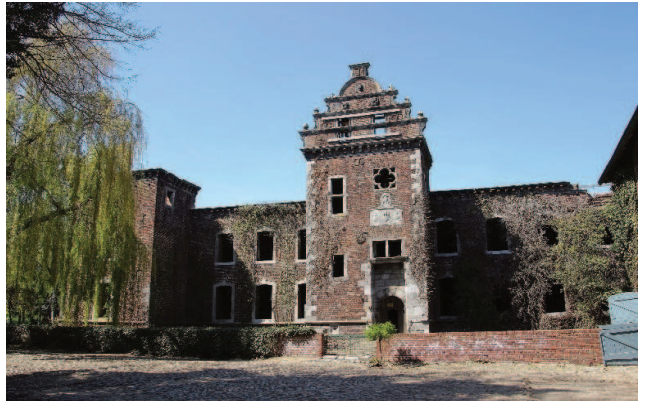
Blick auf die Hauptfassade des Herrenhauses im aktuellen Zustand Foto: Paul Wirtz, Förderverein Kommende Siersdorf e.V.
