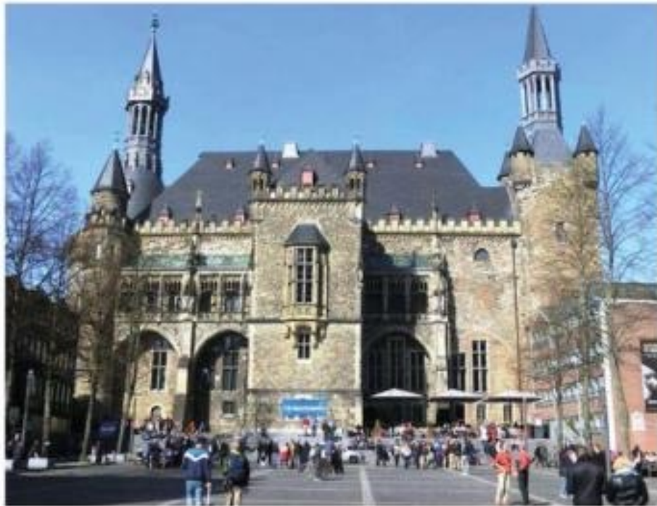
Das Historische Aachener Rathaus. Ansicht vom Katschhof aus.
