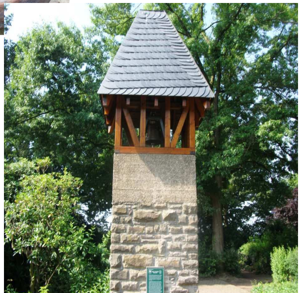
Die Aussegnungsglocke mit erneuerten Glockenstuhl und Schieferbedeckung- Juli 2013
