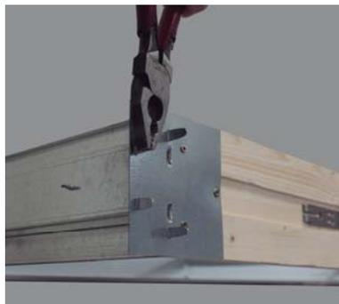
*Montaje sin tornillos mediante el doblado de varias pestañas.*
