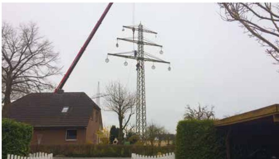
Die alte 110 kV-Leitung Höhe Dorfstraße 75 hängt am Haken. Sie wurde unter die neue 380 kV-Trasse gehängt und die alten Masten konnten verschwinden.
