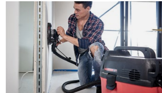
Schleifgeräte können direkt am Sauger angeschlossen werden.
