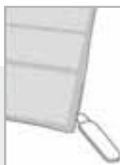
4. Bereits nach einer Aushärtungszeit von ca. 1 Stunde kann die Folie entfernt werden.
