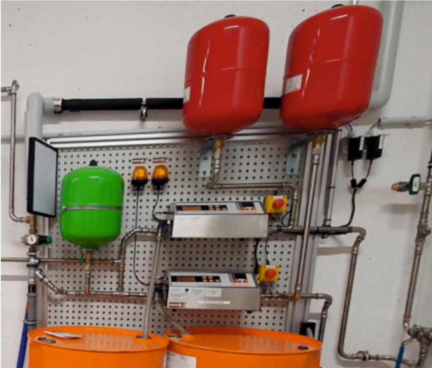
Die Mischstation ist das Herzstück der automatischen Kühlschmierstoffbefüllung.
