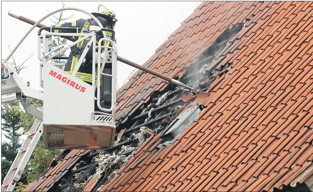
Um an letzte Glutnester zu gelangen, mussten Einsatzkräfte der Feuerwehr Teile des Daches abtragen. Das Feuer selbst hatte zuvor ein großes Loch ins Dach gebrannt. Aufn.: R. Groß
