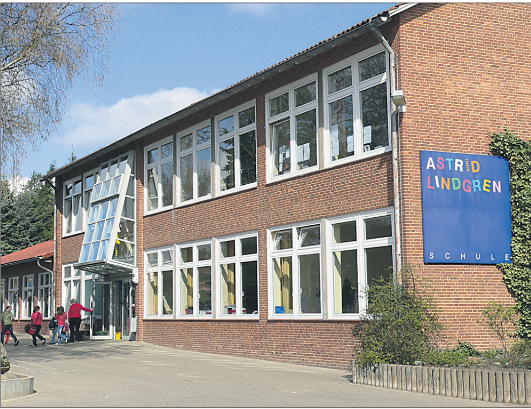
Die Grundschule in Clenze soll saniert und ausgebaut werden. In welchem Umfang das geschieht, hängt davon ab, ob die Grundschulen in Schnega und Bergen geschlossen werden. Aufn.: K.-F. Kassel
