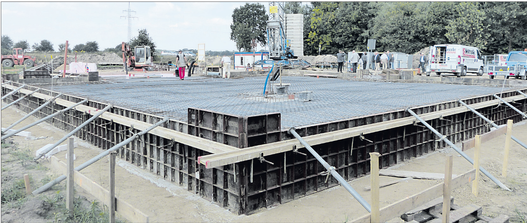
Auf dem Grundstück nördlich der Ortsumgebung in Lüchow baut der Wasserverband Wendland sein neues Verwaltungsgebäude inklusive einer Lagerhalle samt Werkstatt. Kostenpunkt: rund 1,31 Millionen Euro. 2 Aufn.: A. Schmidt
