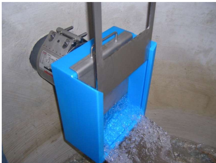
Einbringen der Überfallwand in vorbereitete Nut
