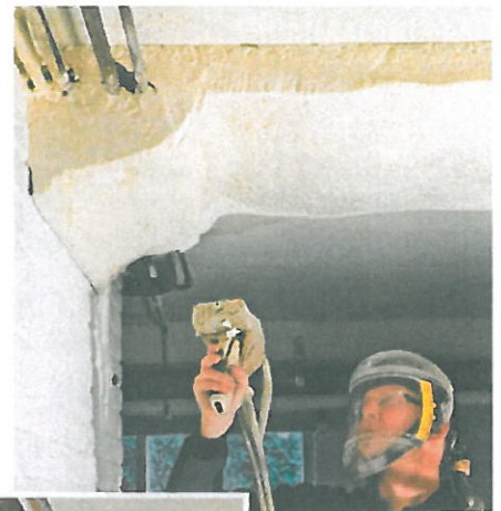
PU-ORTSCHAUM punktet vor allem mit seiner sehr guten Wärmeleitfähigkeit.
