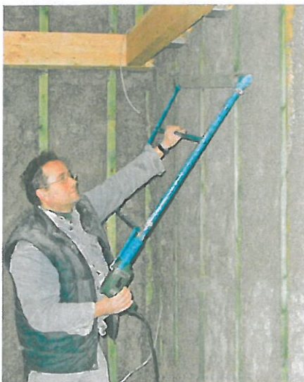
ZELLULOSE ist als Sprühdämmung für Kellerdecken ungeeignet, kann jedoch gut bei Innenwänden und von oben auf Geschossdecken zum Einsatz kommen.
