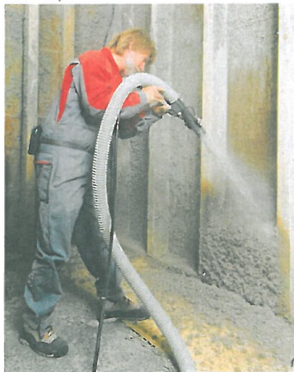
ZELLULOSE ist als Sprühdämmung für Kellerdecken ungeeignet, kann jedoch gut bei Innenwänden und von oben auf Geschossdecken zum Einsatz kommen.
