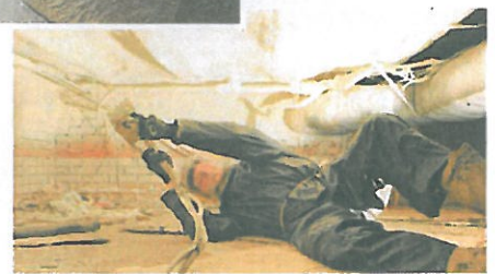
PU-ORTSCHAUM punktet vor allem mit seiner sehr guten Wärmeleitfähigkeit.
