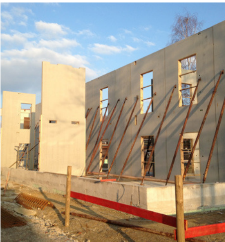
Doppelwände in XXL (6,5 Meter hoch) Kinderkrippe, Freising
