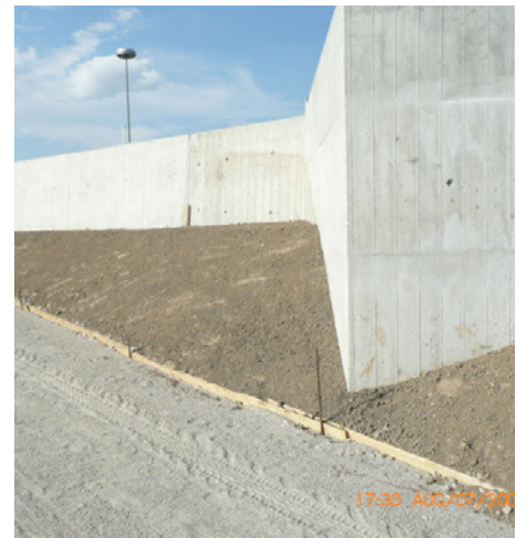
Hochwasserschutz Bogen bei Straubing
