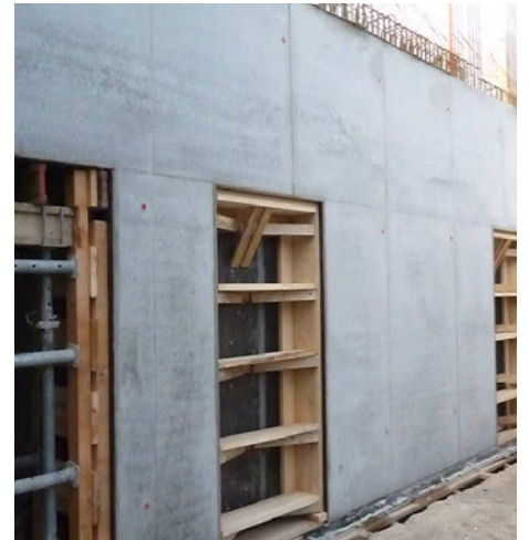
Sichtbeton S3 Mittelschule, Wasserburg
