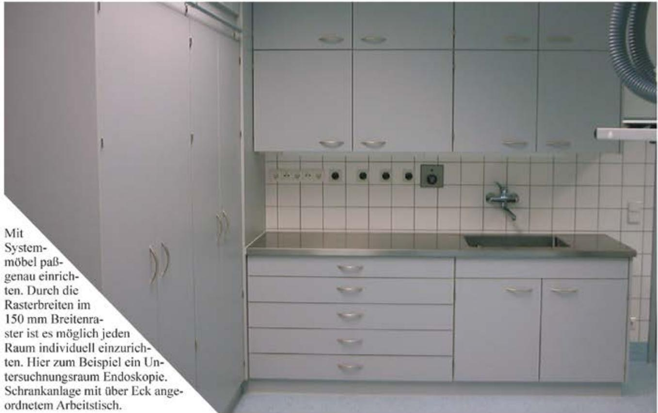
Mit Systemmöbel paßgenau einrichten. Durch die Rasterbreiten im 150 mm Breitenraster ist es möglich jeden Raum individuell einzurichten. Hier zum Beispiel ein Untersuchungsraum Endoskopie. Schrankanlage mit über Eck angeordnetem Arbeitstisch.
