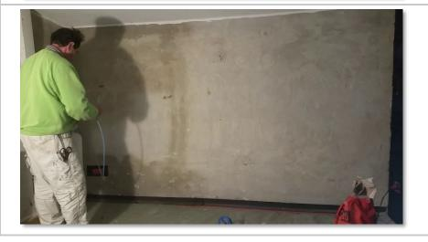
**Vornässen** des Untergrundes vor Auftrag des Haftmörtels. Sowohl bei tragfähigen Altputzen als auch bei Mauerwerken.
