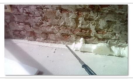
Fuge Estrich/Mauer mit der Pumpspritze leicht vornässen und mit Brunnenschaum ausschäumen. Dieser ist unverrottbar, nicht kapillargängig und nicht leitfähig.
