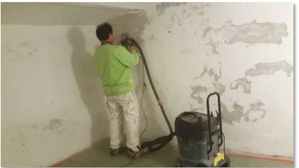
Feste Putzflächen ohne Hohlstellen aus mineralischen Mörteln müssen zumindest alle Anstrichschichten entfernt werden. Am besten mit abrasiver Putzfräse und Absaugung.
