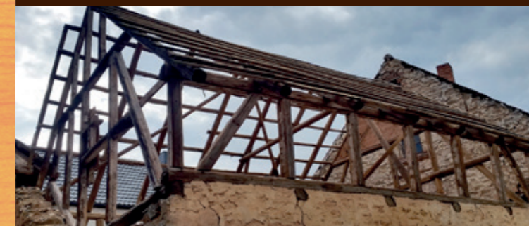
ALTER DACHSTUHL – DEMONTAGE
