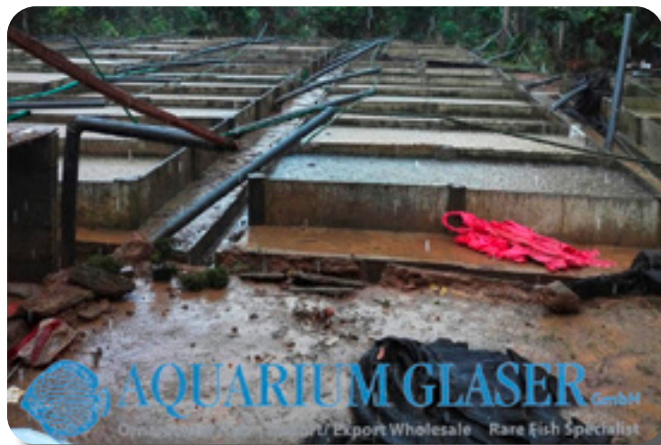
(Ein teil der Anlage NACH einem Unwetter)
