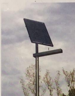
Eine hochmoderne Straßenbeleuchtung befindet sich seit einigen Tagen am Sportplatz. Am Weg zum Trainingsplatz wurden 3 LED-Leuchten mit Solaranlage und Batterien installiert. Mit Eintritt der Dämmerung beginnen sie im Sparmodus schwach zu leuchten. Nähert man sich den Lampen, sorgt ein eingebauter Bewegungsmelder dafür, dass die Lampen den Weg hell ausleuchten. So finden unsere Spieler in der dunklen Jahreszeit vom Trainingsplatz sicher zurück ins Clubhaus.
