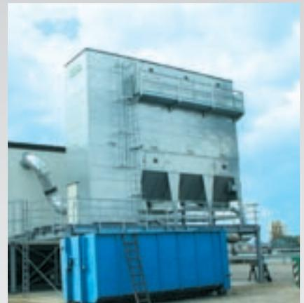
Die Filteranlagen von Schuko sind in ihrer Vielseitigkeit und Leistungsfähigkeit unübertroffen. Sie sind als Filter im Überdruckbereich genauso einsetzbar, wie als Filter im Vakuumbetrieb. Das Austragungssystem kann dem jeweiligen Einsatzbereich angepasst werden.
