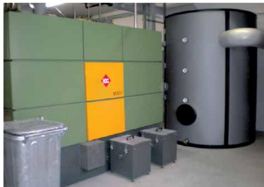
In pratica la caldaia HDG M300-400 viene dotata di un serbatoio di accumulo. La pompa di carico a giri variabili fornisce una potenza effettiva e la portata appropriata.
