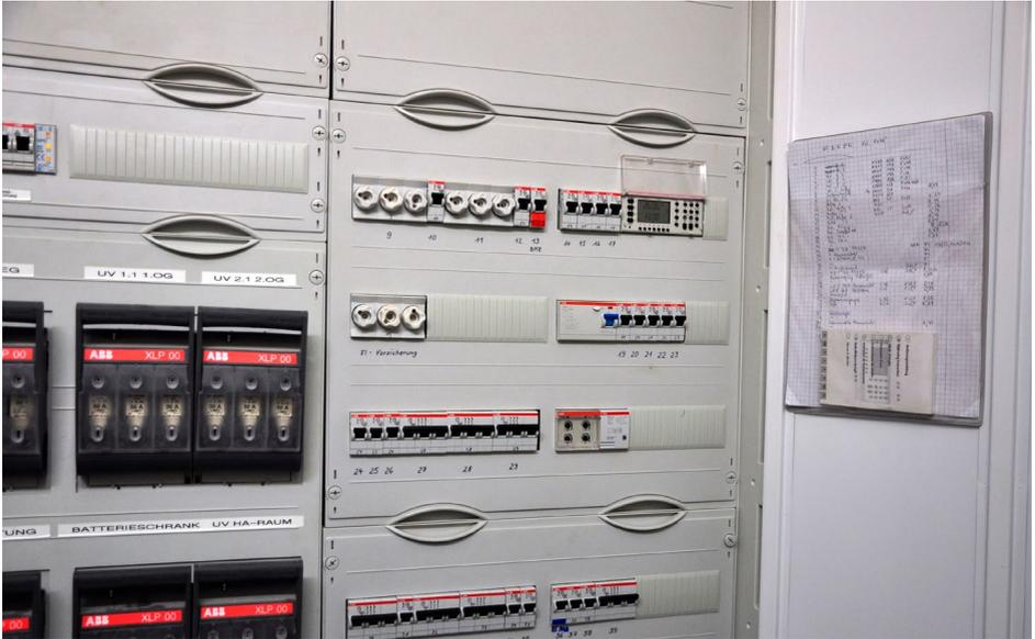
Abb. 4 Stromkreiskennzeichnung und zugehörige Dokumentationen einer elektrischen Unterverteilung
