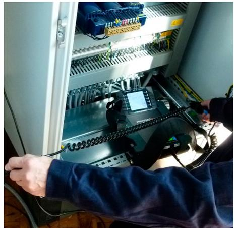
Abb. 11 Schutzleiterwiderstandsmessung; Messung der niederohmigen Schutzleiterverbindung; Schaltschrank
