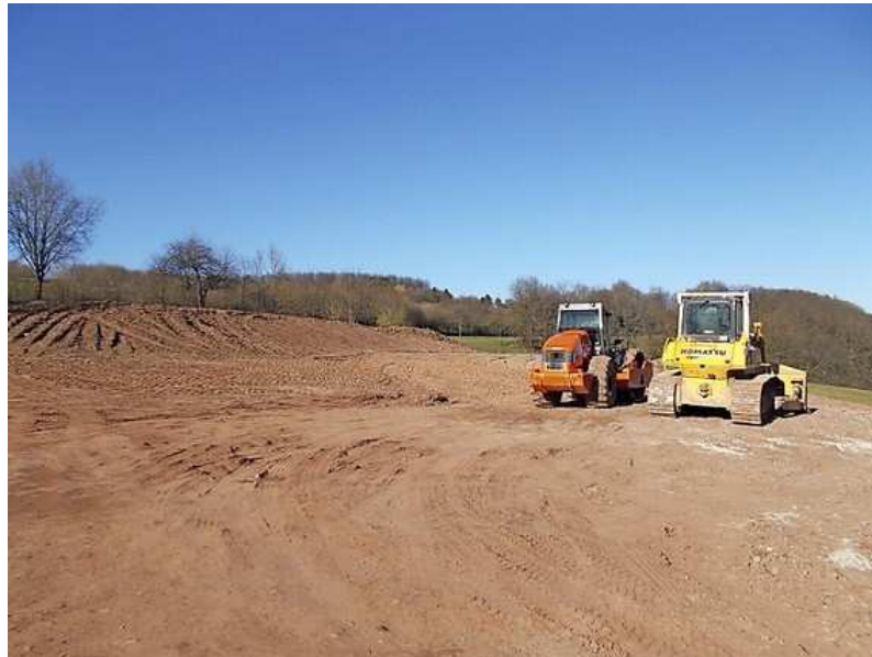
Beim Ersten Golfclub Westpfalz rollen zeitweilig die Bagger und Planiermaschinen. Foto: rb Bild 1 von 1
