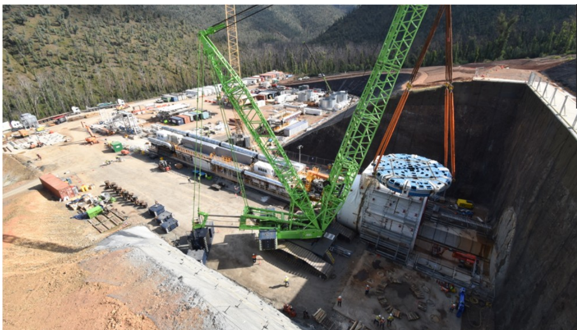
Figura 1 - La TBM in fase di assemblaggio
