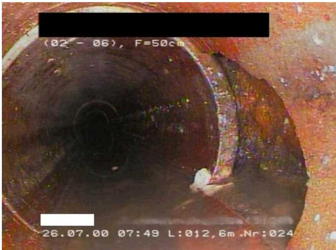
Abbildung 8: fehlende Wandung im Steinzeug-Rohr | Foto: ISAS GmbH
