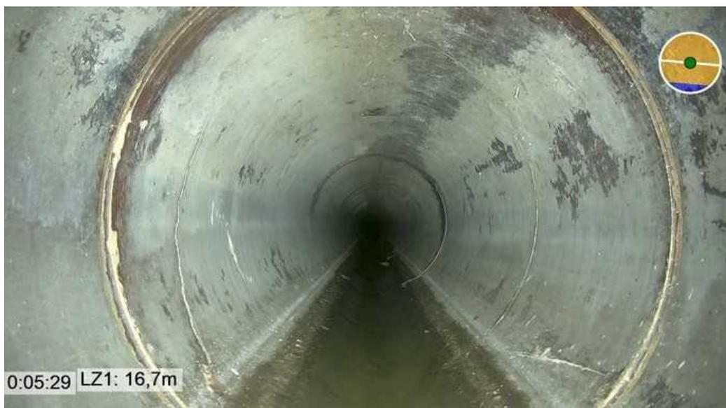
Abbildung 13: Riss mit 1 mm Breite, höhere Bildauflösung | Foto: ISAS GmbH
