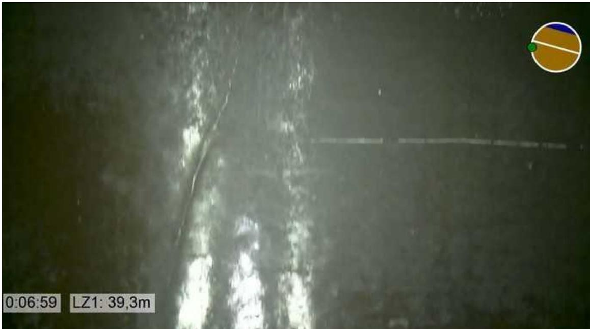
Abbildung 6: Momentaufnahme radiales Abschwenken des schmalen Teils des exemplarischen Risses | Foto: ISAS GmbH
