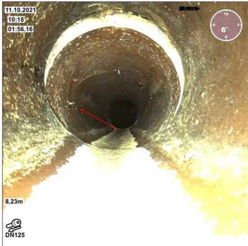
Abbildung 9: Haarriss oder Spinnwebe am linken Kämpfer? Auf dem laufenden Video ist sichtbar, dass das mit dem roten Pfeil markierte Insekt die weiße Linie im Vorbeifliegen zum Schwingen bringt – es ist eine Spinnwebe! | Foto: ISAS GmbH
