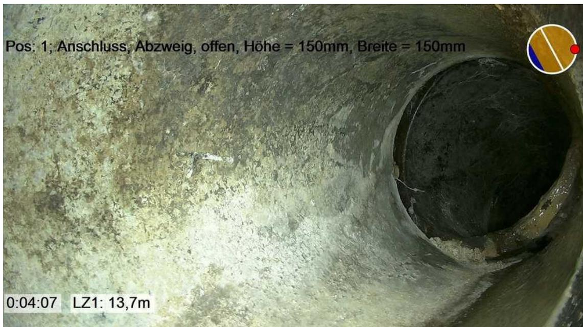
Abbildung 1: Lageversatz mit Infiltration im Anschlussrohr, außerhalb der relevanten Systemgrenze | Foto: ISAS GmbH
