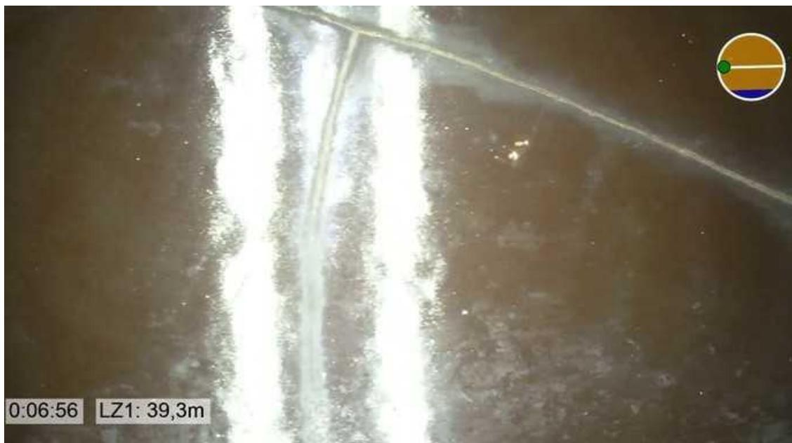
Abbildung 5: Momentaufnahme radiales Abschwenken des breiteren Teils des exemplarischen Risses | Foto: ISAS GmbH
