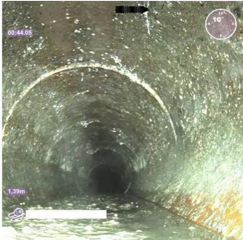
Abbildung 12: Kameraposition unterhalb des Querschnittsmittelpunktes | Foto: ISAS GmbH
