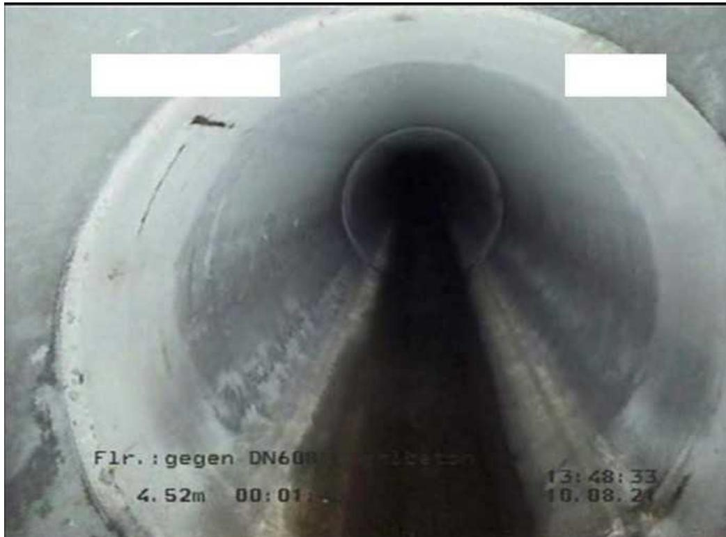
Abbildung 11: Kameraposition oberhalb des Querschnittmittelpunktes | Foto: ISAS GmbH
