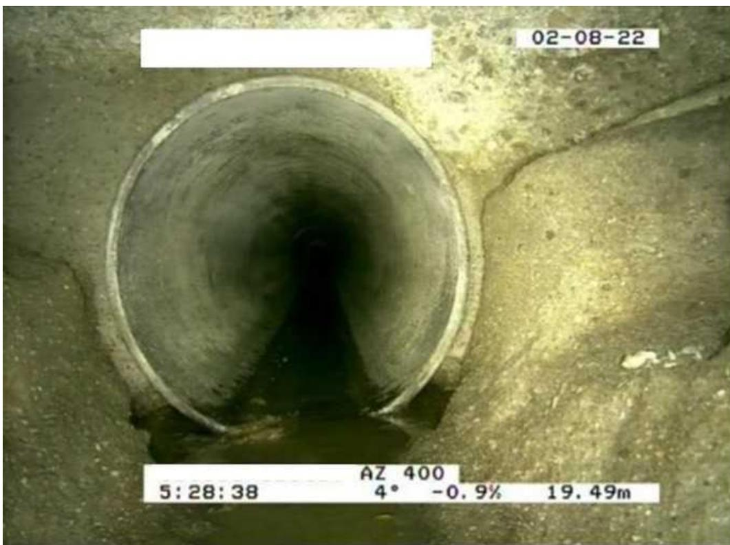
Abbildung 3: Versatz an der Anbindung zwischen Schachtgerinne und Rohranfang des folgenden Kanals, außerhalb der Systemgrenze | Foto: ISAS GmbH
