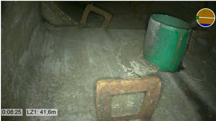
Abbildung 2: Einragender Stutzen im Endschacht, außerhalb der relevanten Systemgrenze | Foto: ISAS GmbH
