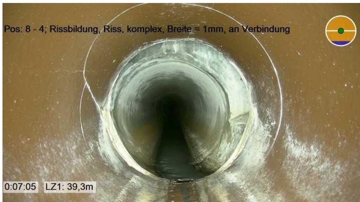
Abbildung 4: Gesamtansicht des exemplarischen Risses mit komplexer Struktur | Foto: ISAS GmbH
