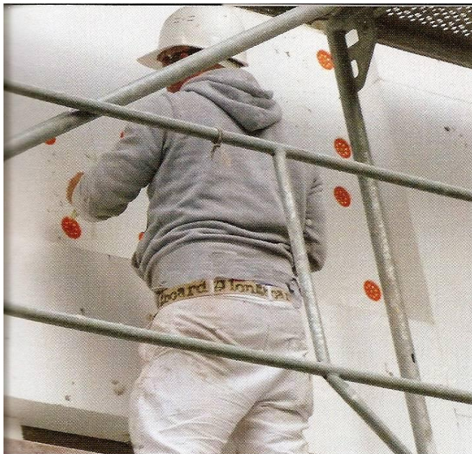
▲ LES PLAQUES D'ISOLANT ONT ÉTÉ POSÉES SELON LE PRINCIPE DU CALER-CHEVILLER
