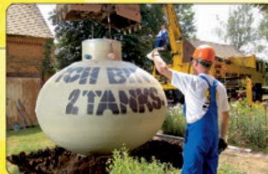
Holzpellets müssen gegen eindringendes Wasser und Feuchtigkeit geschützt werden, um zu verhindern, dass die Pellets verklumpen und so die Austragung erschwert wird. Die Doppelwandigkeit des Pelletserdtanks von Haase garantiert dafür absolute Wasserdichtheit. Durch den Erdbau des Tanks werden die Pellets frostsicher gelagert und die minimalen Temperaturschwankungen tragen dazu bei, dass sich kein Kondenswasser im Behälter bildet.
