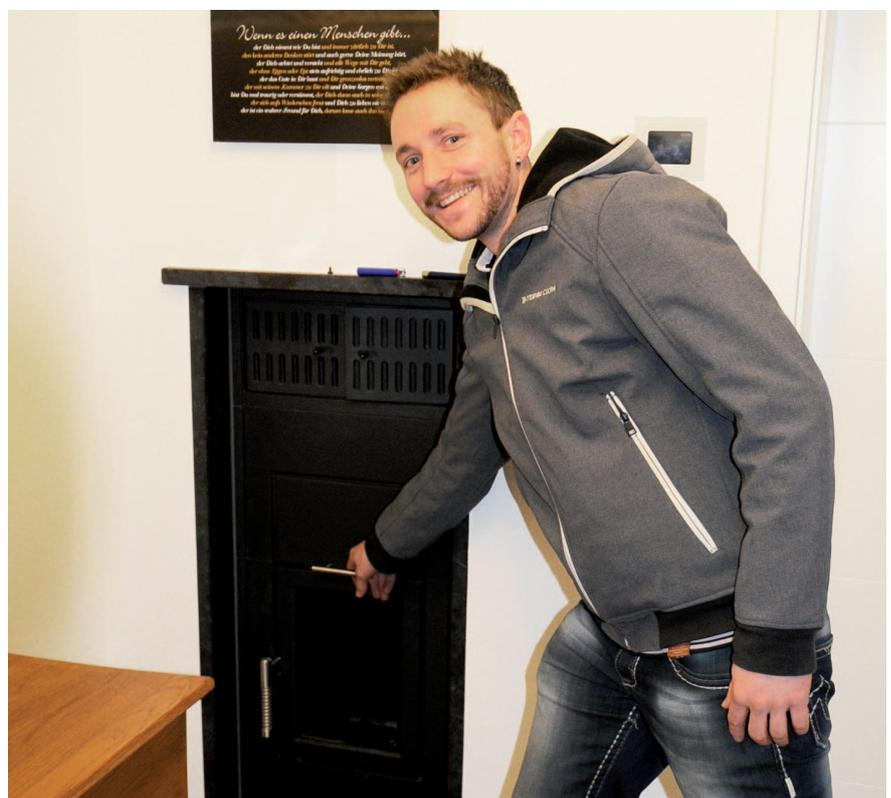
**Gute Ergänzung zur echten Hybridanlage: Mit einem Handgriff kann Georg Buchner die Energie umleiten. Dann gibt der Heizeinsatz 70 Prozent der erzeugten Wärme an den Heizkreislauf ab.**
