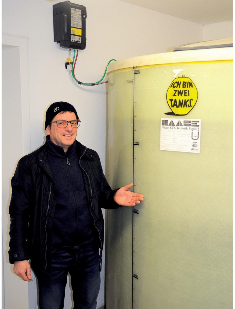
**Albert Willberger erläutert wichtige Vorteile von Haase-Tanks: Passt als Bausatz überall durch, ist sicher, doppelwandig, benötigt keine Auffangwanne, bleibt formstabil und hat eine transparente Tankwandung. Dank einer Skala lässt sich der Heizölbestand schnell ablesen.**
