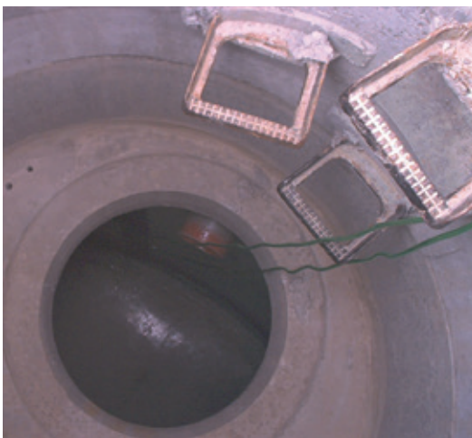
Abb.: Einbringluke und Ansicht nach der Vor-Ort-Montage einer doppelwandigen Auskleidung für eine Abwassergrube mit 50.000 l Nutzvolumen
