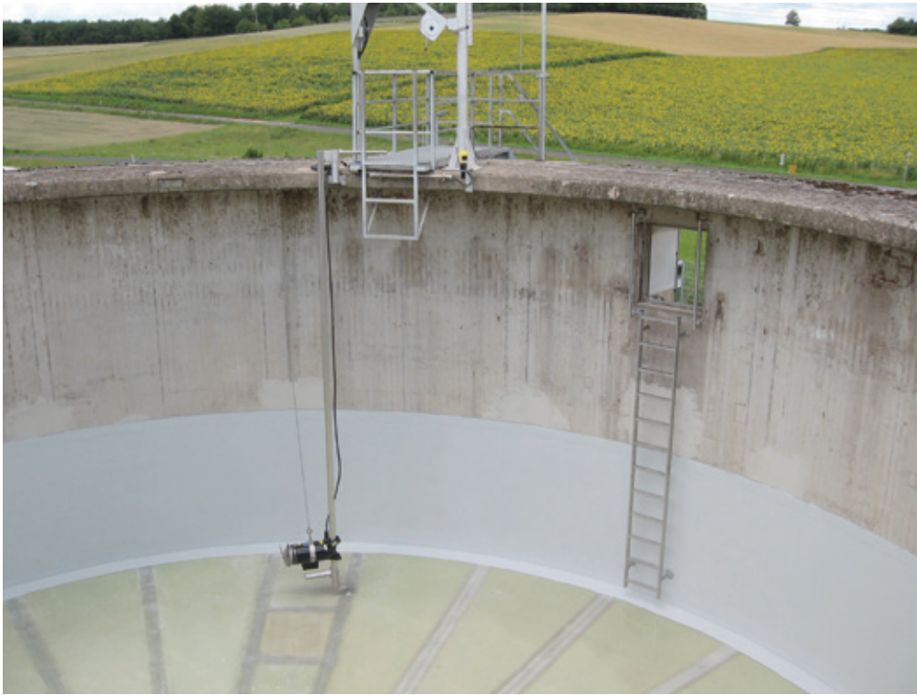
Abb.: GFK-Auskleidung für ein Becken zum Auffangen von Klärschlamm
