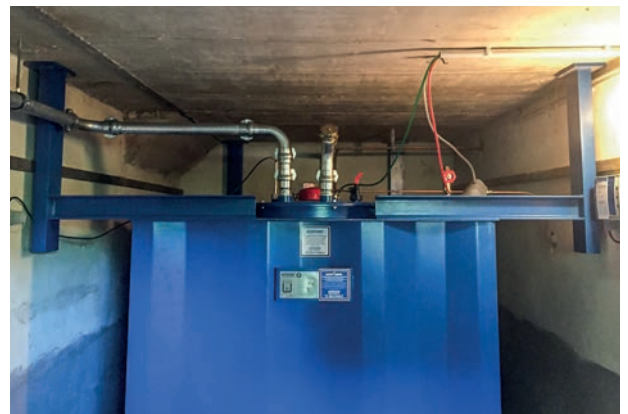
Auftriebssicherung standortgefertigter Stahltank
