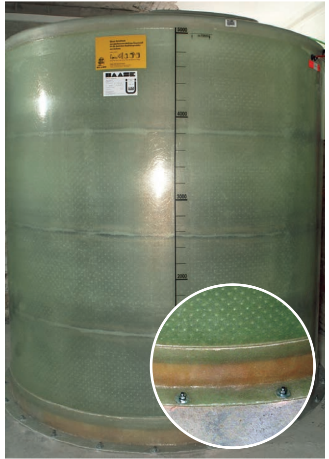
Auftriebssicherung GFK-Tank
