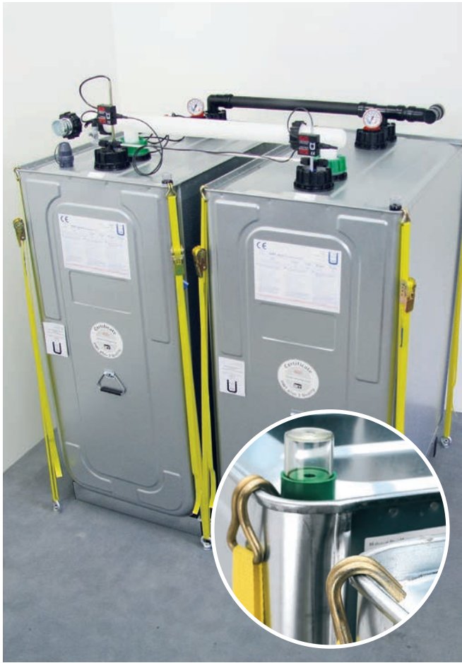
Auftriebssicherung Batterietank
