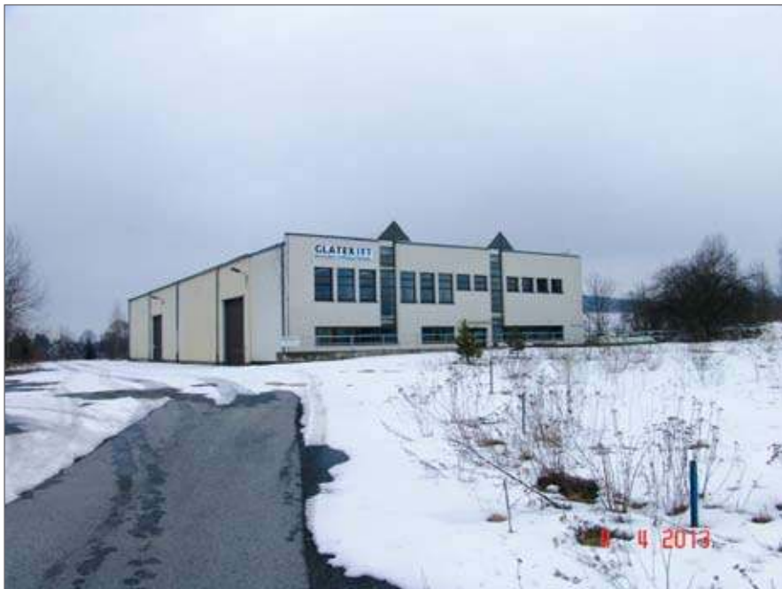
Zufahrt zur ehemaligen Abfüllhalle
