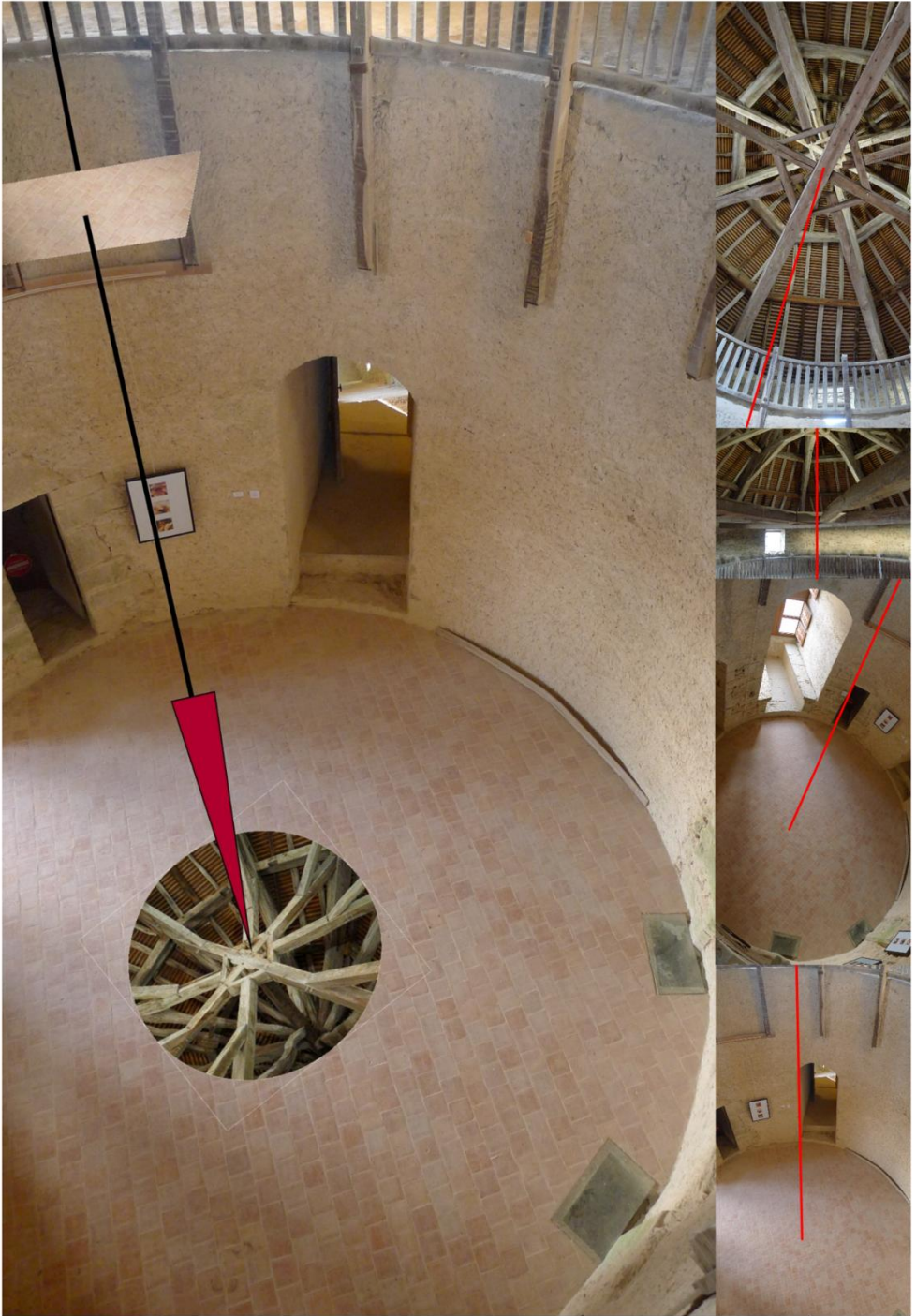
Réflexions faites Repérage pour l'installation en salle de Garde
