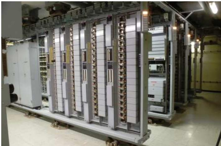
*Vermittlung im eh. Ausweichsitz des Landes NRW, eine der ganz wenigen EMD-Vermittlungen die noch am Originalplatz voll funktionsfähig sind. Sie diente dem Fernmeldeverkehr im Bunker so wie mit der Außenwelt. Verglichen mit einer „normalen Vermittlung“ weist sie eine Besonderheit auf: Alle Gestellreihen sind mit Dämpfern montiert, die Stöße abfangen sollen.*
