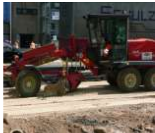
Tief- und Straßenbau
