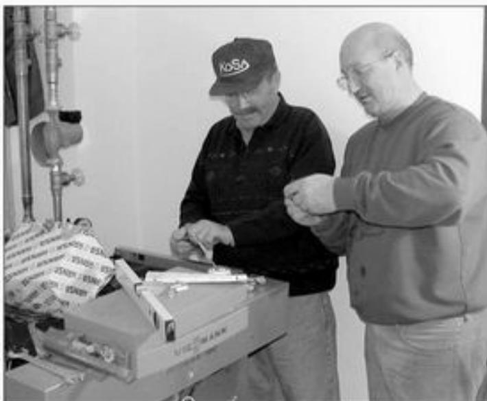
**Es werde warm:** Erwin Diegel und Gerd Höhn (rechts) beim Reinigen von Kupferwinkeln und -bögen an der Heizungsanlage.
