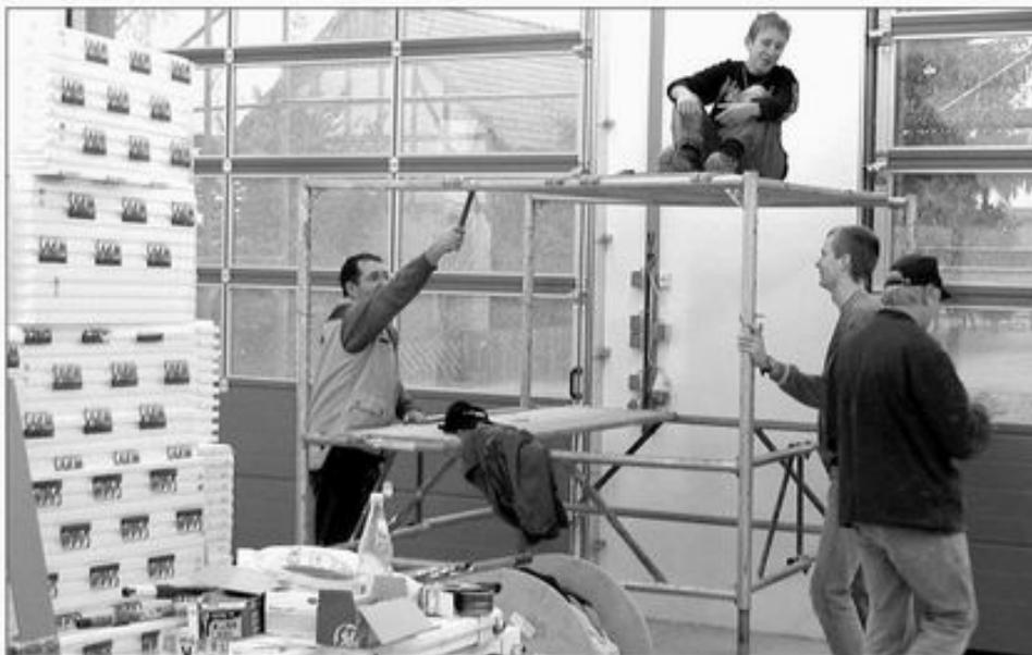
**Es werde Licht:** Mit Hilfe eines rollenden Gerüsts zogen Heinz Kersch, Patrick Bardt, Rainer Piechoczek und Edgar Bardt (von links) Elektrokabel in die zuvor verlegten Kanäle ein. Links im Bild sind die restlichen Styroporplatten für die Außenisolierung zu sehen.
