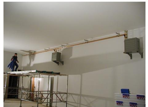
Fertige Decke und Montage der Heizgebläse
