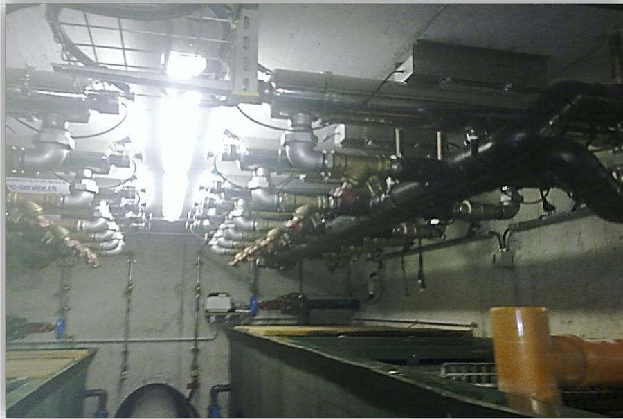
Das konventionelle Reinigungssystem des Wasserkreislaufes wurde in einem Technikkeller eingerichtet. Es bestand aus mehreren kleinen Becken mit verschiedenen Materialien zur Vergrößerung der Oberfläche, beispielsweise speziellen Bürsten. Zudem wurde eine leistungsfähige UV-Desinfektionsanlage installiert, welche in Bild 1 an der Decke montiert erkennbar ist.
