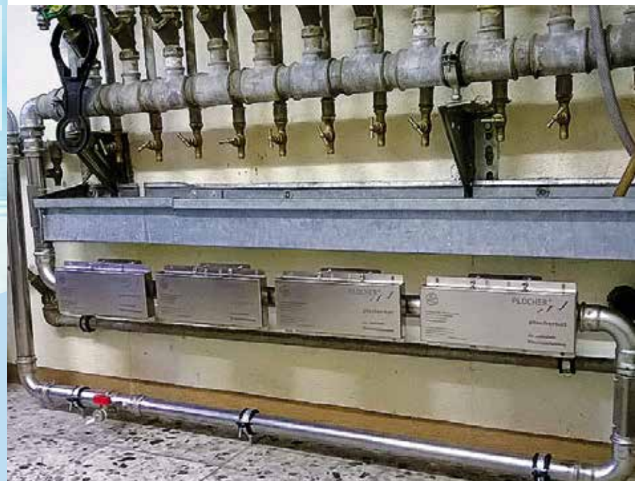
Montagebeispiel Mehrfamilienhaus: plocherkat in Reihe montiert
