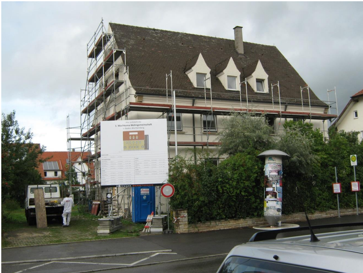
07. September 2011, Tafel mit am Umbau beteiligten Unternehmen
