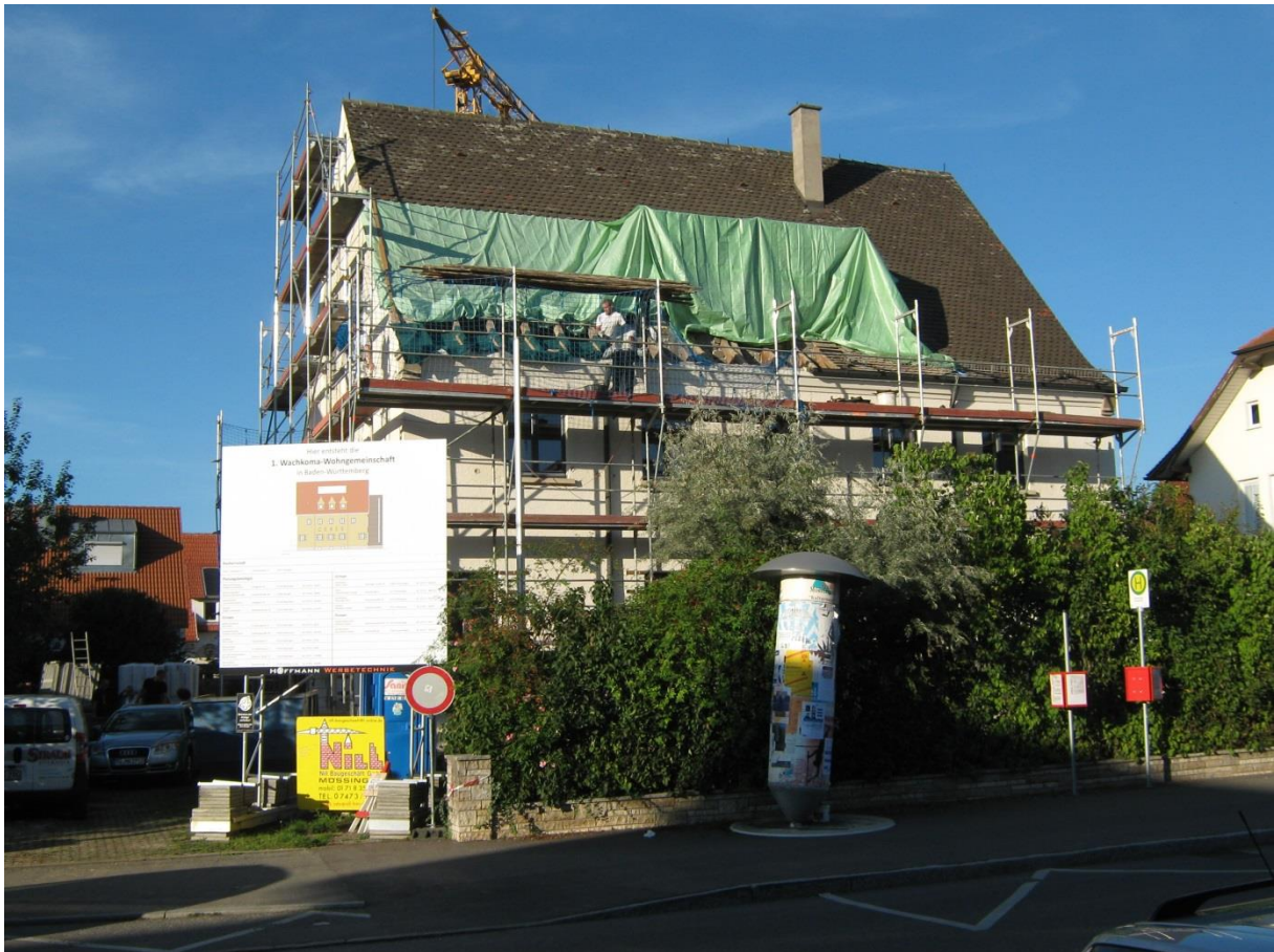
21. September 2011, Beginn der Dacharbeiten mit Dachisolation
