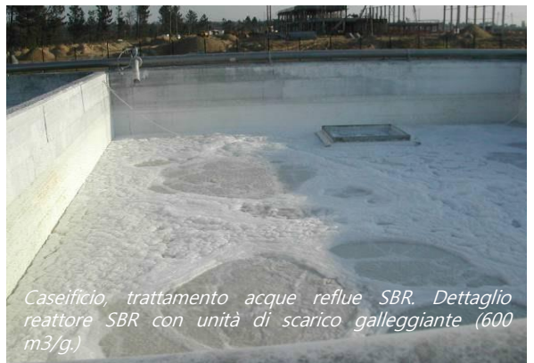
Azienda vitivinicola, trattamento biologico MBBR. Dettaglio vasca di sedimentazione e omogeneizzazione, vasca metallica, (300 m 3 /g).
