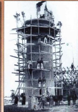
So könnte das auch in Balje gewesen sein: Richtfest auf Fehmarn - Staberhuk 1903
