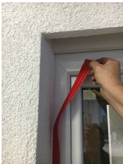
Herausziehen des Klemmprofil zur Aktivierung
