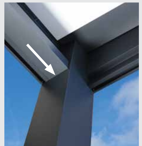
Wasserablenkung über Rinne direkt in Stützpfeuern
