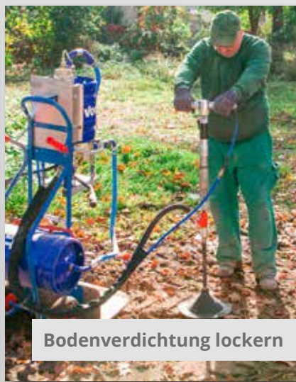
Boden lockern und belüften
